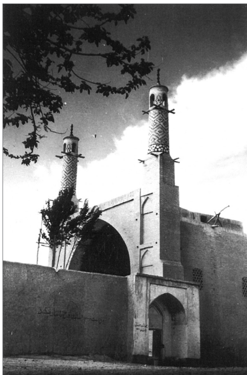
ورودی شرقی منارجنابان - اواخر دهه ۵۰
